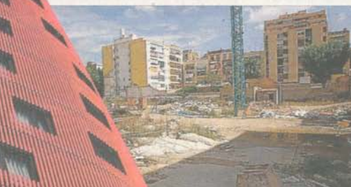
TRAVELODGE ▶ La cadena, propiedad de Dubai International Capital, anunció el pasado martes que la promotora Citygrove invertirá 28 millones en la construcción del segundo hotel de Travelodge en Catalunya, en la calle de Llacuna, en el distrito 22@ de Barcelona.
