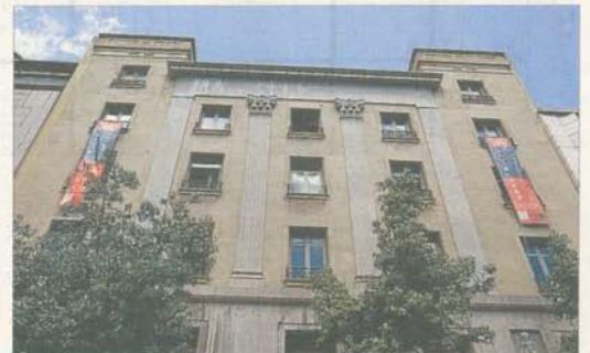
ROOM MATE ► Una de las últimas licencias concedidas por el Ayuntamiento de Barcelona es para el segundo hotel de Room Mate en la ciudad, en la calle de Fontanella, con apertura prevista para marzo del 2012 y una inversión de 19 millones. Es propiedad de Caboel.
