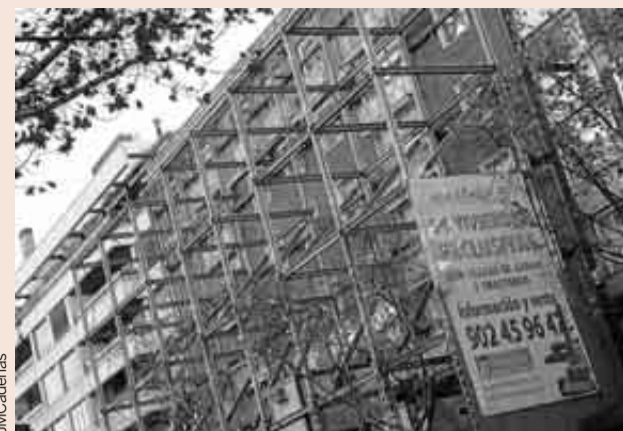
Imagen de viviendas en construcción en Madrid.
